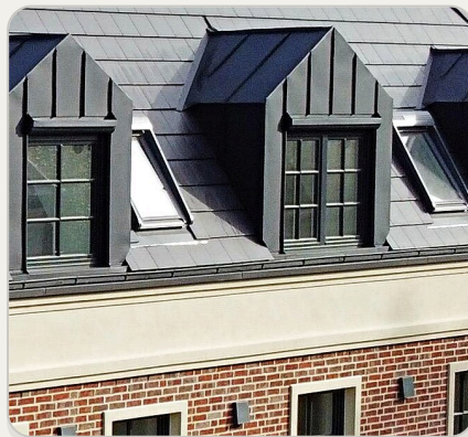
Gauben im Mansarddach
